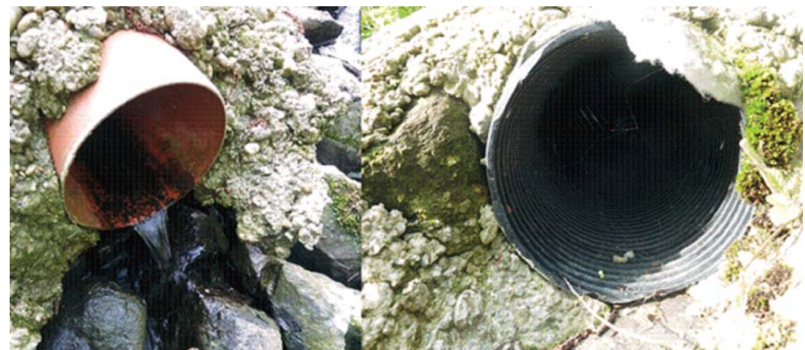
Vývod drenážneho potrubia (na pravej strane vývod nefunkčnej vetvy D)
